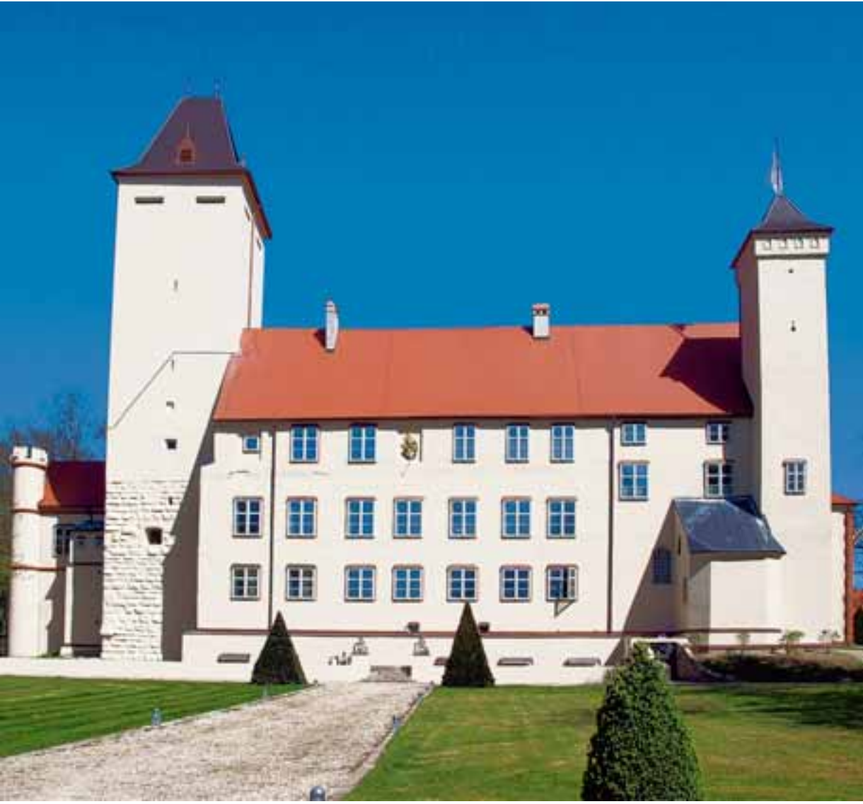
Das Schloss Hofhegenberg von Süden mit dem 2010 bis 2012 wiederaufgebauten Bergfried. Der neue Besitzer Peter Löw hat seit 2009 das heruntergekommene Schloss außen und innen aufwendig saniert und restauriert. Foto: Landratsamt
