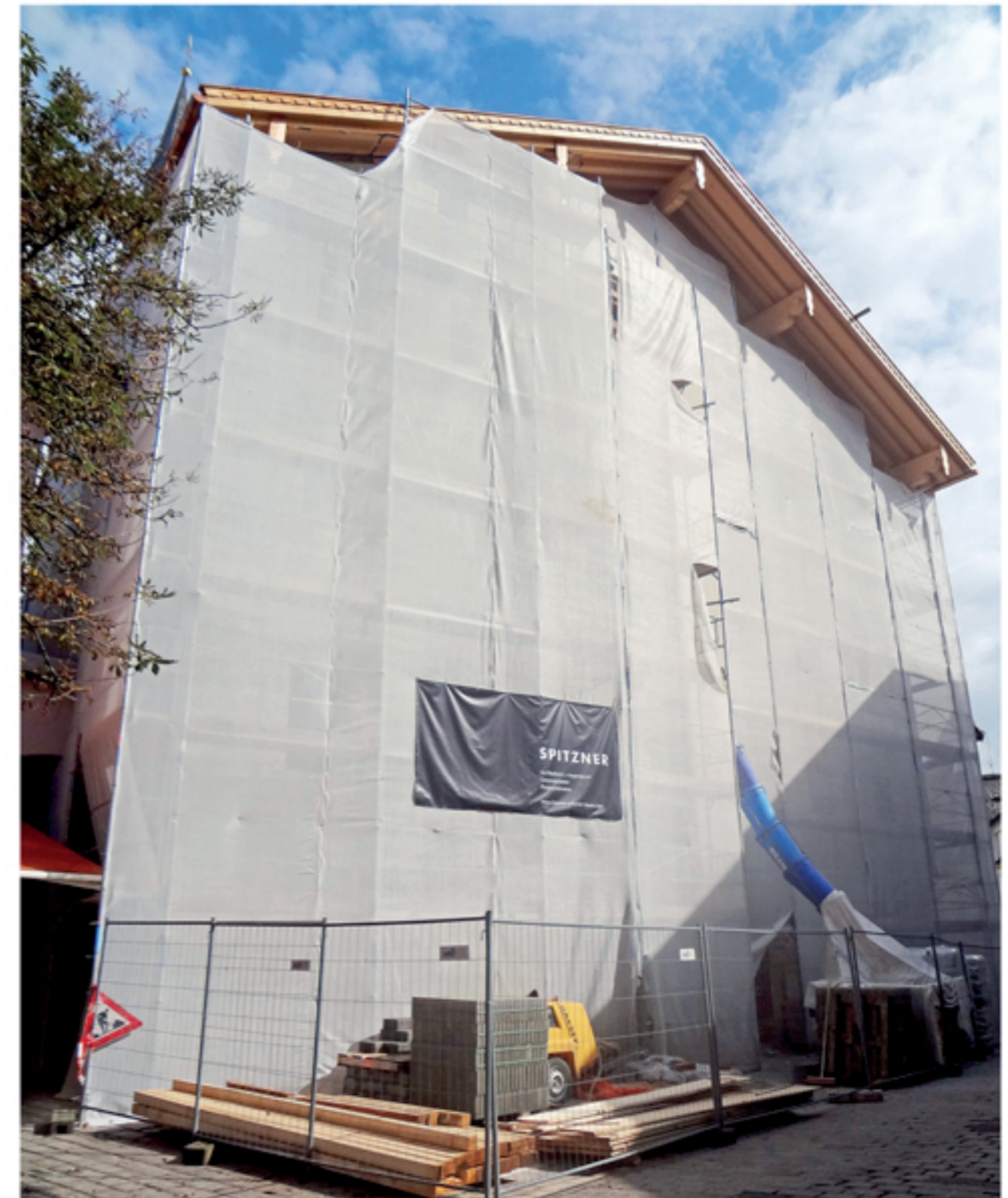
Das Haus Hinterstadt Nummer 15 wird innen und außen mit viel Liebe zum Detail kostenaufwändig saniert und renoviert. Ende November wird die Baupläne gelüftet. Fotos: Fusser
